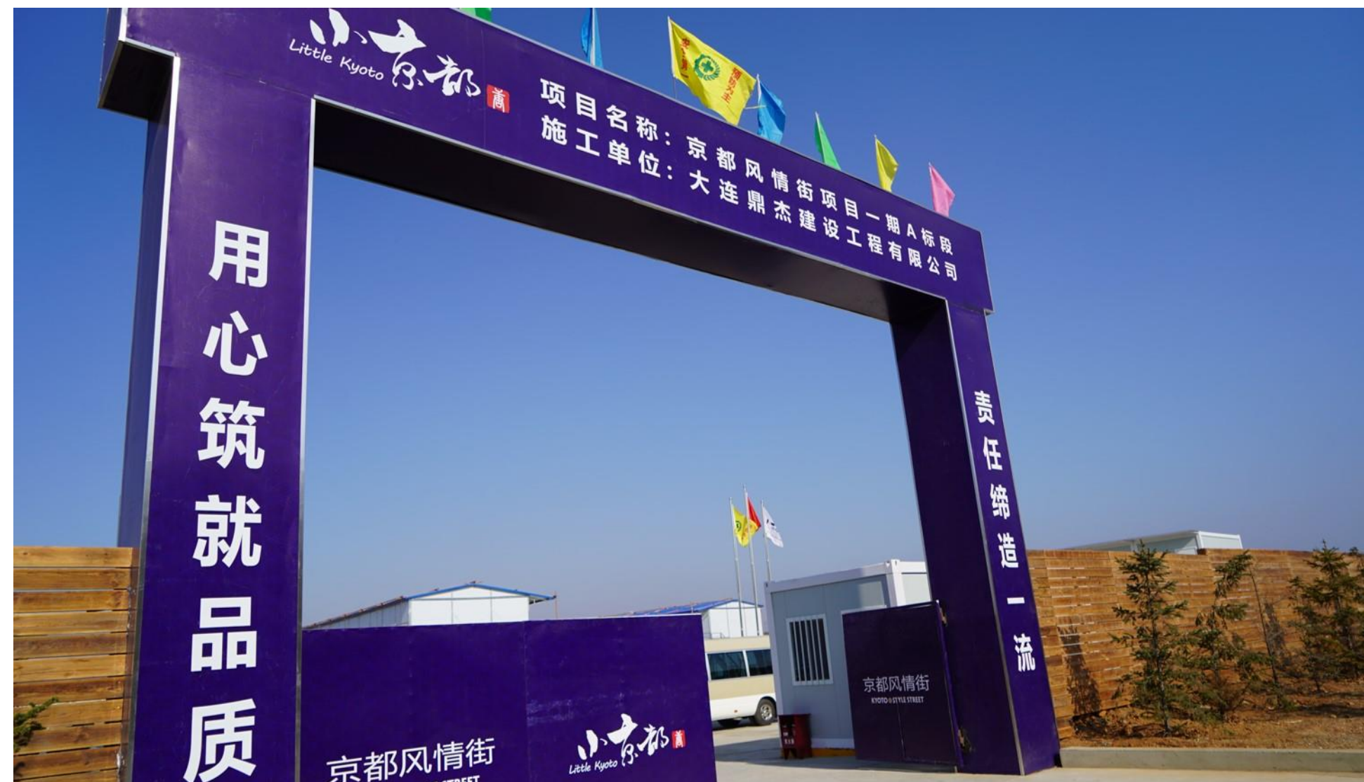
工事現場の入口(建設地の南側)
