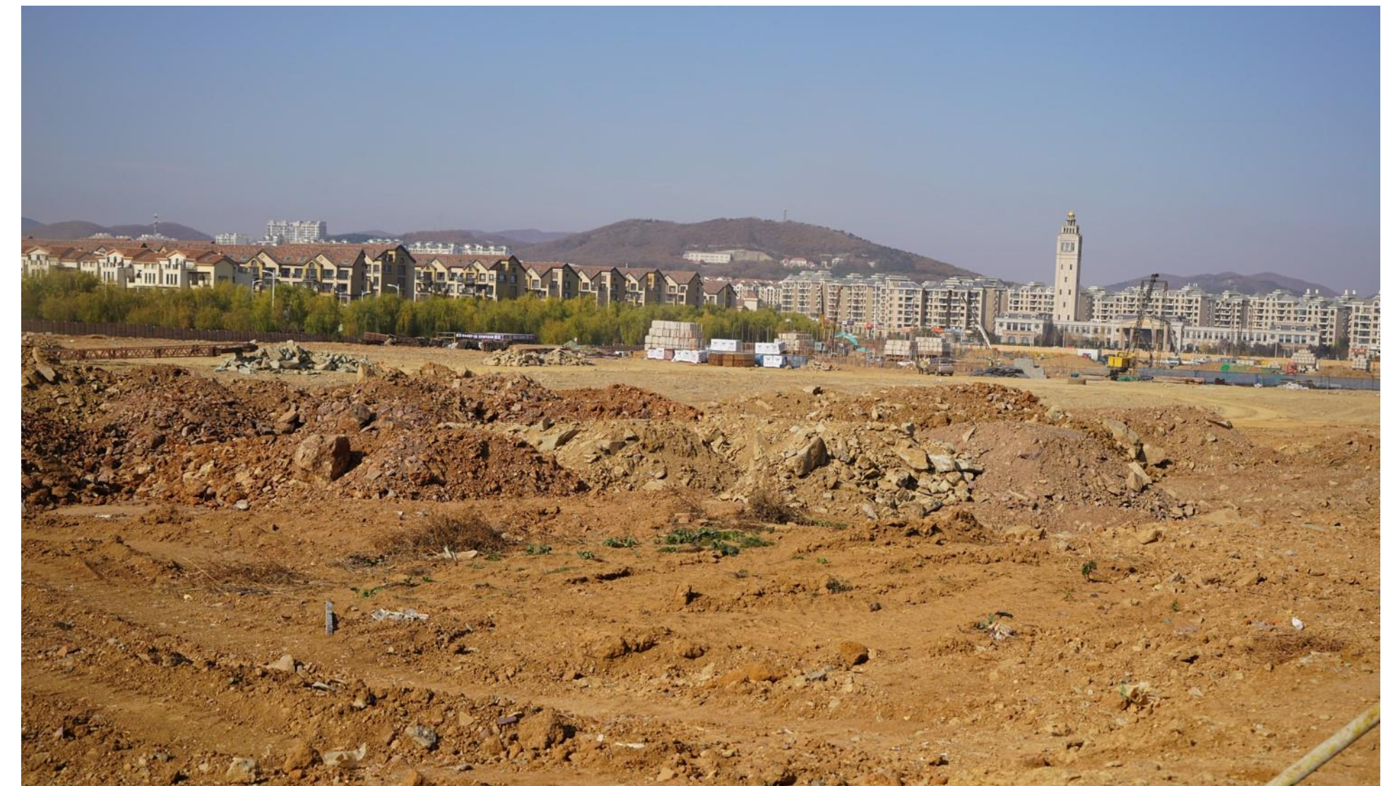
周辺はマンションや別荘が広がる（建設地の南側から北を望む）
